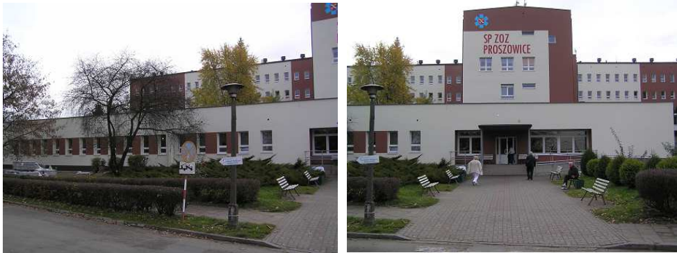
Fot. Budynek główny po termomodernizacji.
