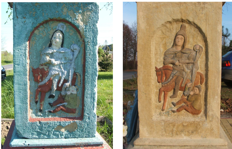
Kapliczka pw. św. Floriana w Radziszowie – detal – przed i po konserwacji
